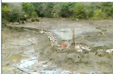
ため池の改修工事
