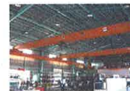
天井クレーン基
