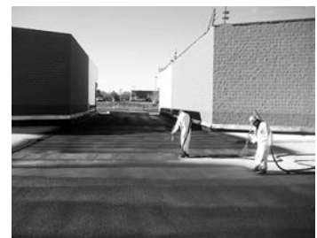
「ウエットスーツ」施工の様子
