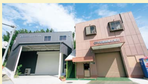
2016年には新工場が完成した
