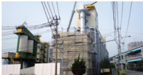
同社が手がけるプラント設置の現場
