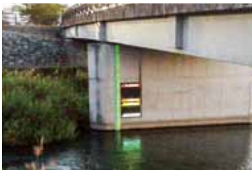
橋に設置した電光水位指示標
