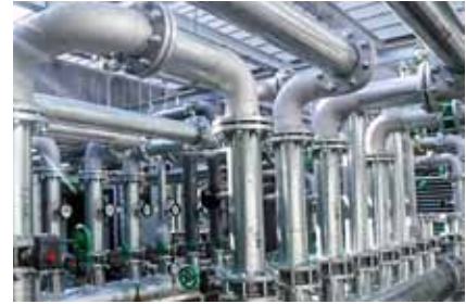
工事を手がけた配管
