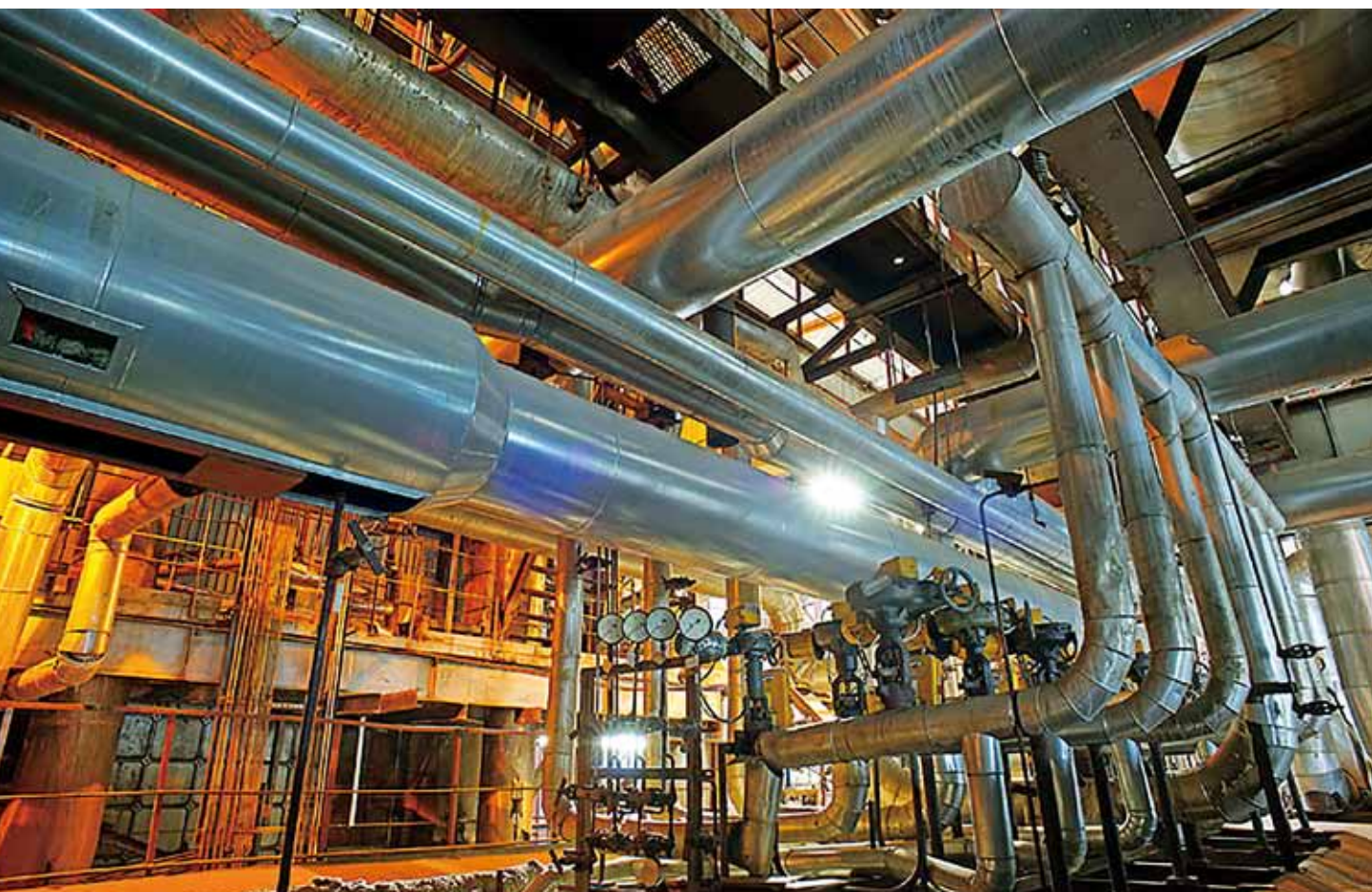
保全工事を手がけたプラント
