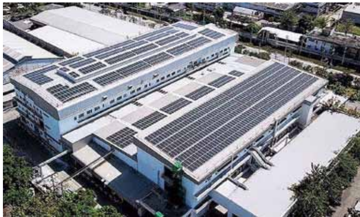
屋根置き太陽光発電所
