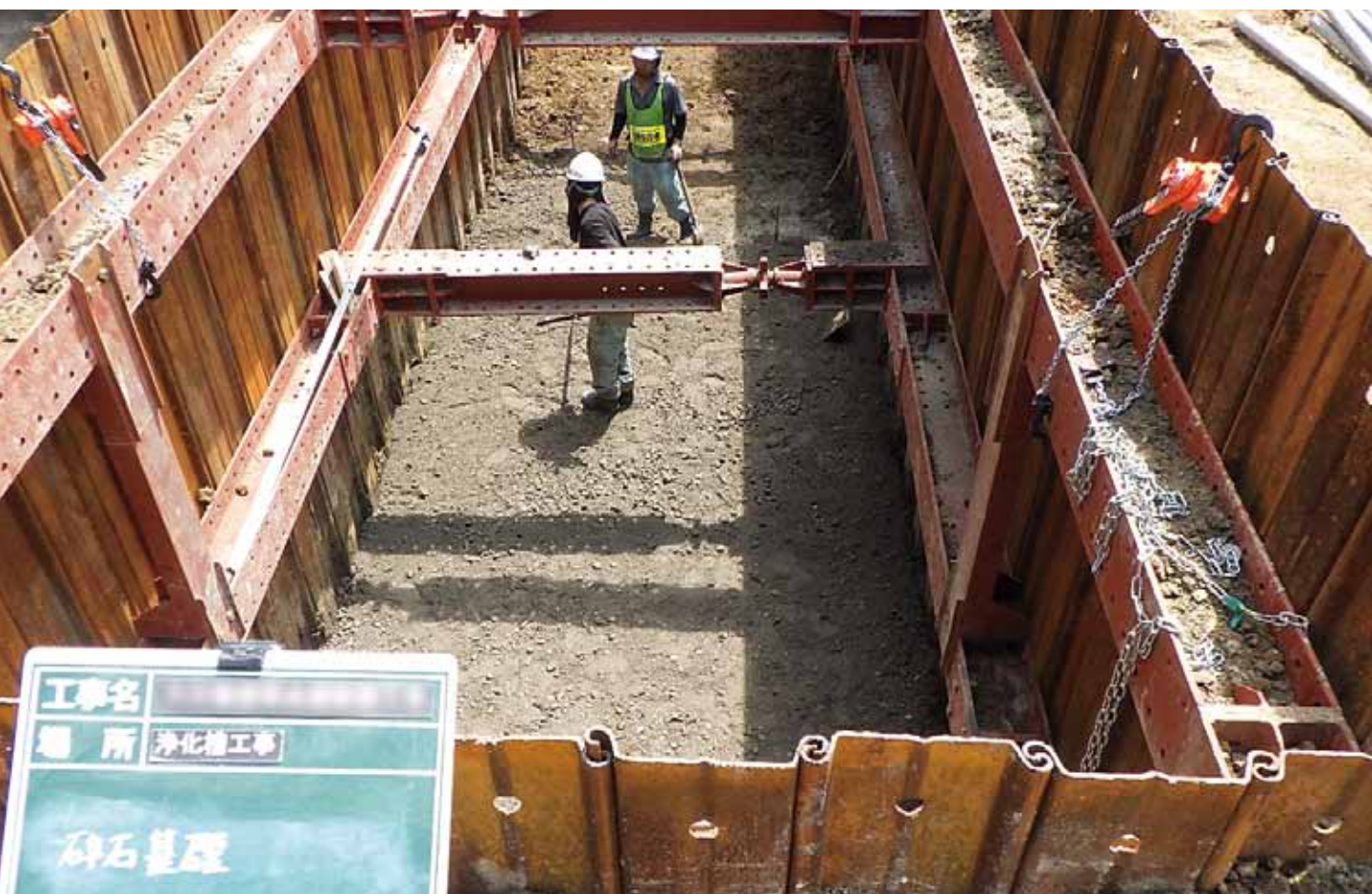
三友式土留工事例
