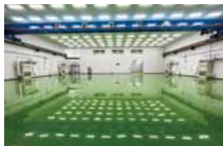
2022年7月宮若工場新棟に竣工したクリーンルーム
