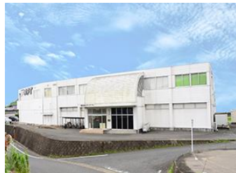
本社/本社工場・装置工場 (太宰府)
