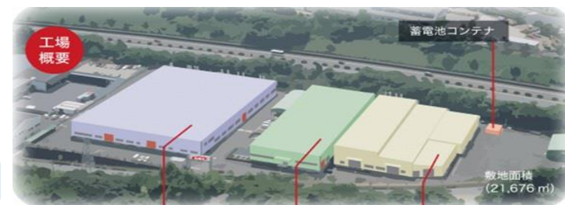
シートメタル加工工場 A棟(5,656㎡)
