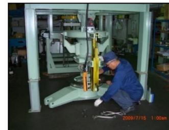
吹付け装置組立風景
