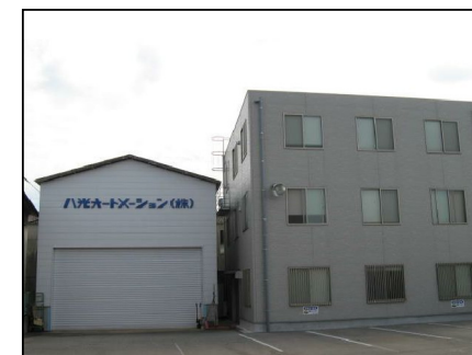
工場門・開発棟
