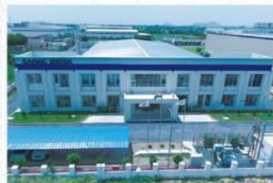
SANAC INDIA PVT. LTD.
